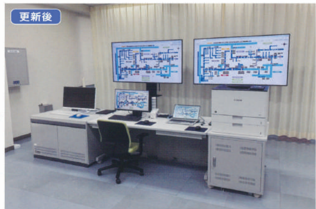
利根中央総合管理所表示装置・操作端末の更新 クラウド化に伴う局内サーバー機器等の撤去
