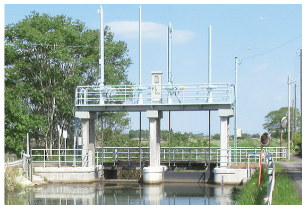
◎手子堰(県営ストックマネジメント事業) 【加須市下樋遣川地内】
