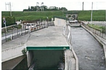
葛西分水工(羽生市)
