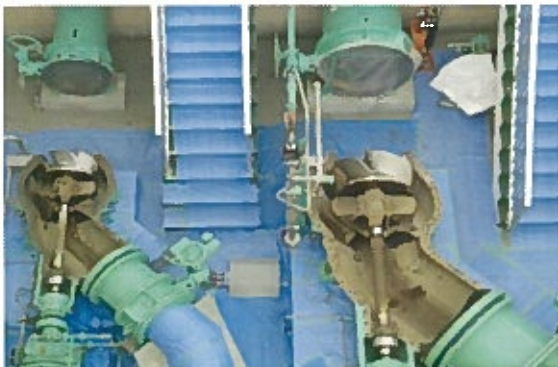
◎金野井揚水機場オーバーホール
