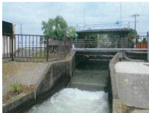
◎南方用水路取水口 【羽生市大字小須賀地内】
