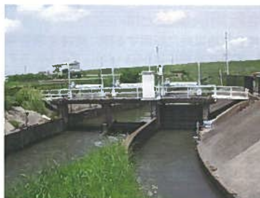
◎佐波分水堰(加須市外野地内)
