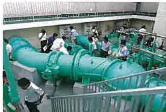
◎金野井揚水機場 φ900×2台、φ600×1台 (春日部市) (関東農政局による視察 H26.7)
