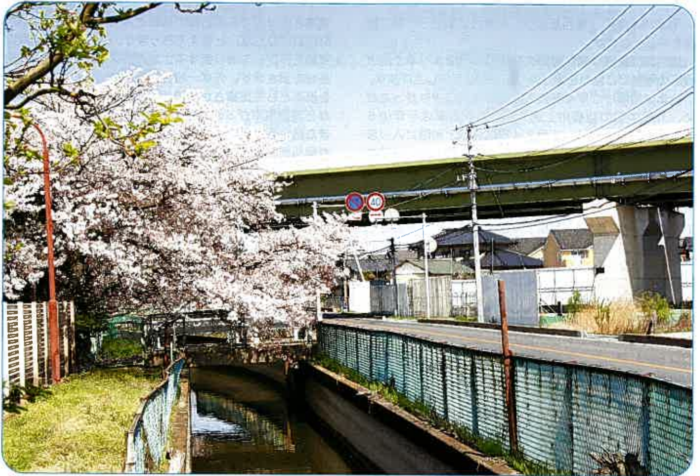
幸手市 中郷用水路と建設中の圏央道
