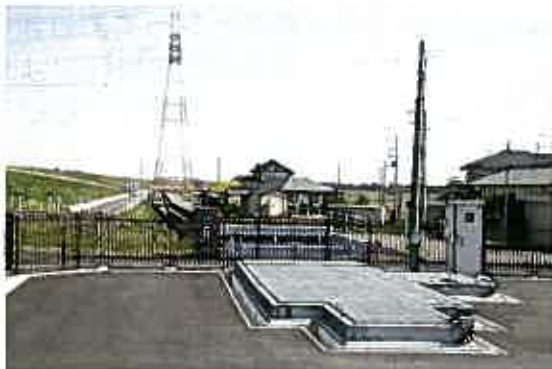
◎江戸川堤防強化対策事業(なごみ堤)により移設した新田着水槽(吉川市内)
