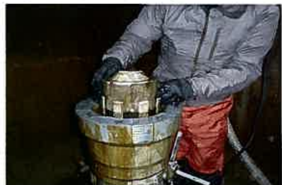
◎新田導水路空気弁分解清掃
