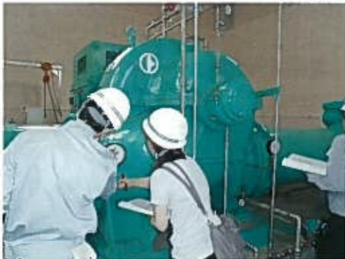
◎農水省によるポンプ点検研修会(二郷半領揚水機場)
