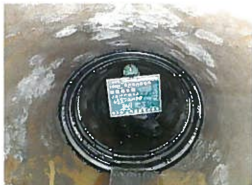
◎新田導水路(Ø1100)管継手補修
