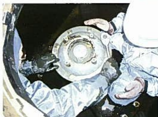
◎新田導水路空気弁清掃作業
