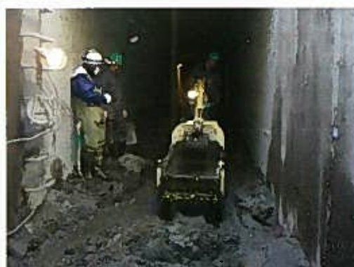
◎金野井揚水機場江戸川樋管内浚渫作業
