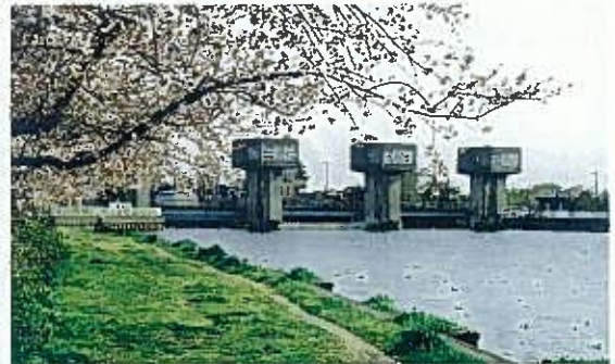
古利根堰（松伏町）（対岸は越谷市）
