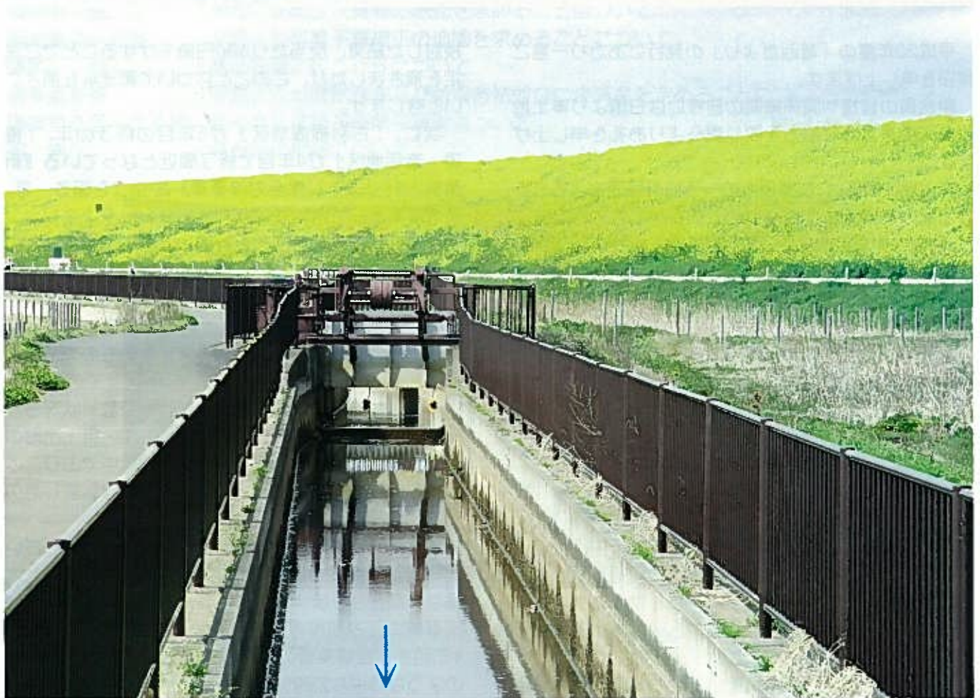
吉川市 新田用水路 (深井新田堰)
