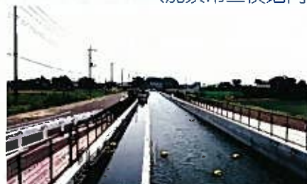
(分水路) (本線水路) 最大流量 約3.9m³/s 約17.4m³/s 分水路・・合理的に配水するための副水路。
